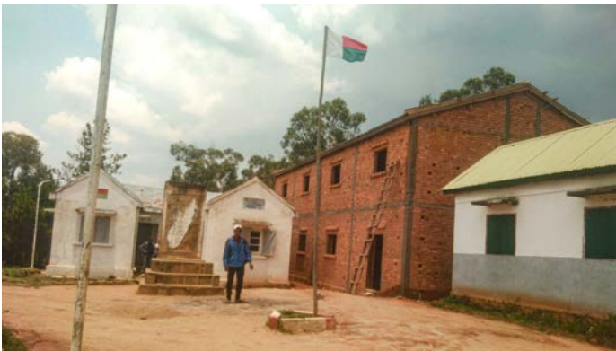
La salle communale de Belanitra bientôt achevée
