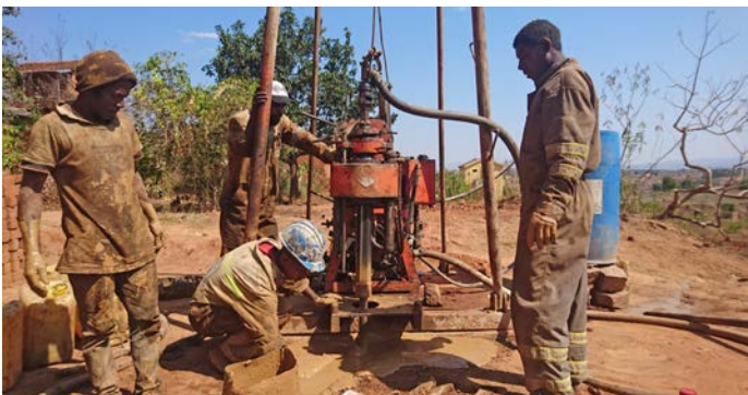
Le forage du puits de Manarintsoa est enfin terminé.
