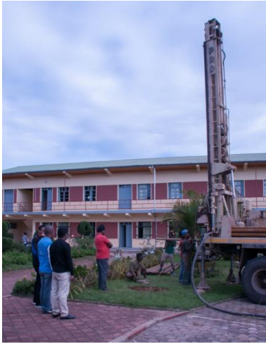
Mise en place du forage P2.
