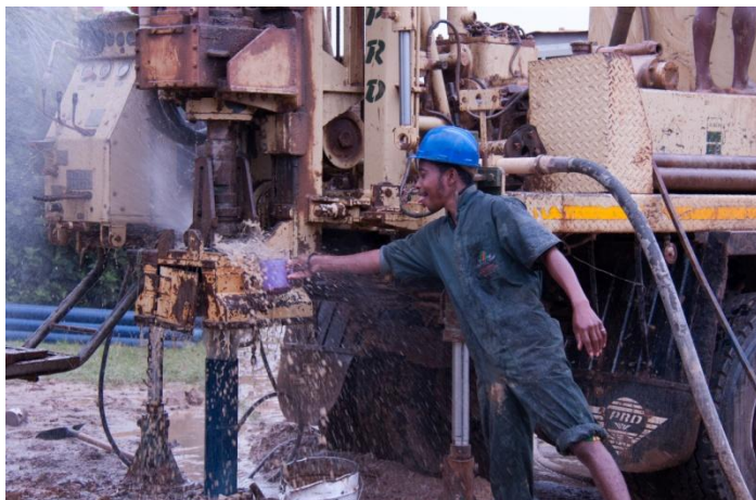
L'eau du forage, chassée à l'air-lift.
