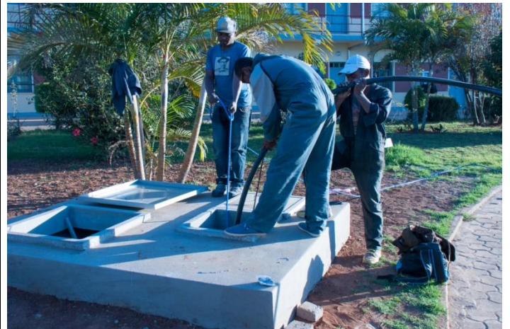
Mise en place de la pompe définitive, active 2h/j pour les besoins actuels de l'ESSVA. La chambre de puits a été construite en fin de forage.
