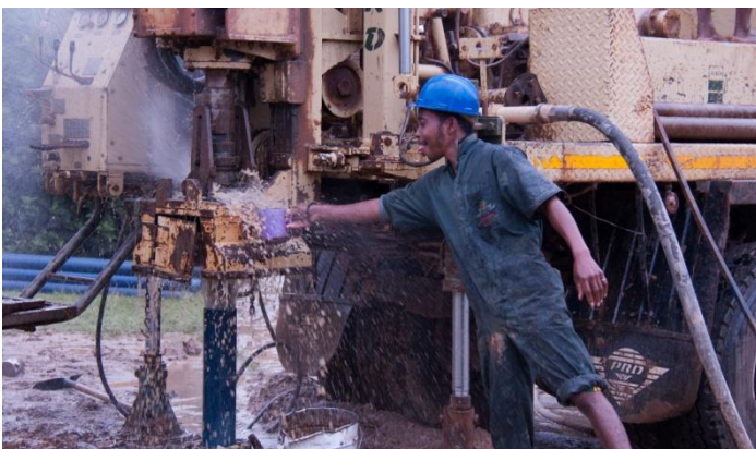
Das Wasser spritzt wegen « air-lift » Spülverfahren
