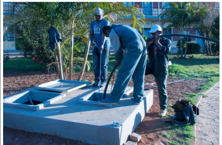
Die definitive Pumpe wird im brandneuem P2-Brunnenkammer
