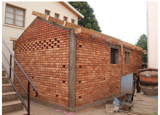
Das Sanitärgebäude nimmt Gestalt an
