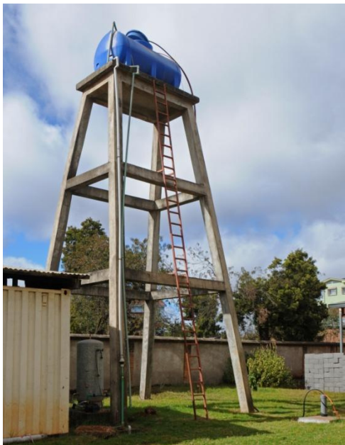
Wasserturm, mit Brunnenkopf rechts
