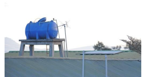
Solarzellen rechts auf dem Dach
