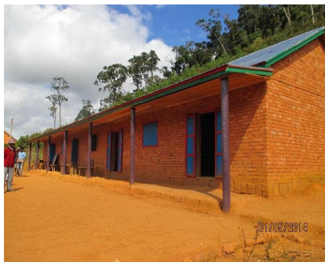
Nouveau bâtiment de l'école secondaire
